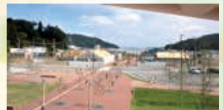
商店街の建設工事が進む駅前プロムナード。湾左手には女川魚市場や水産加工団地が並ぶ。
