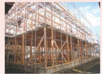
伊勢地域の建設現場
